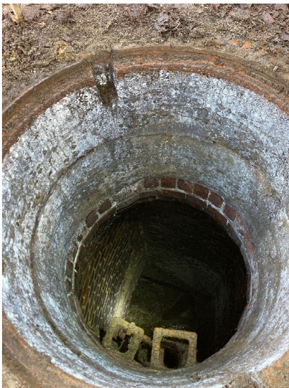
Foto 4: Schacht 1038 (Reichsbahnstraße / Furtweg)
