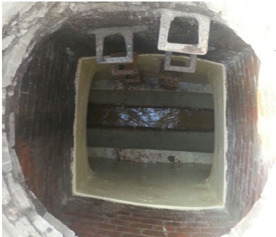
Foto 6+7: Beispiel für eine Ausführung umlaufendes Laminat 10cm über Scheitel
