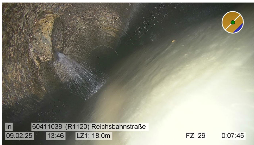
Foto 1: Einragender Abzweig (Stat. +18,0 m) in der Haltung 1038 (DN 500)
