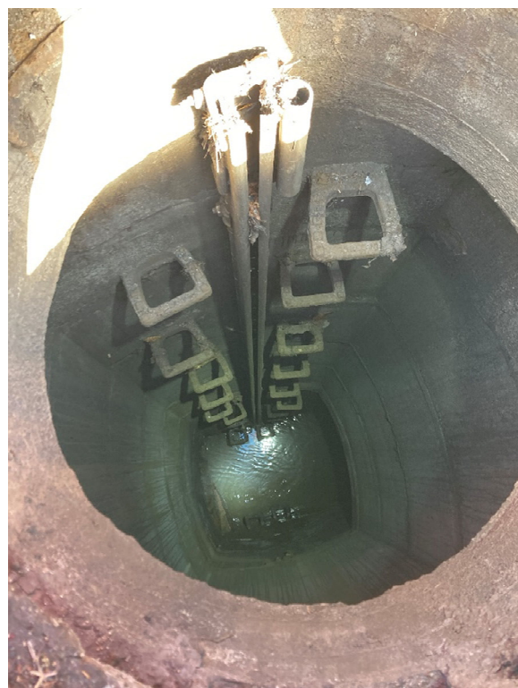
Foto 5: Schacht 1046 (Kieler Straße / Reichsbahnstr.)
