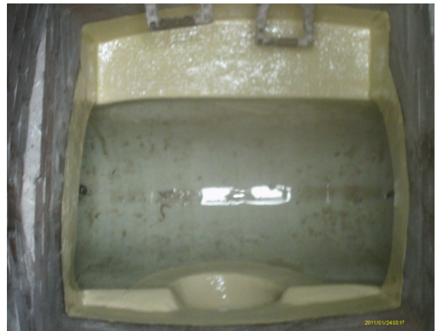
Foto 6+7: Beispiel für eine Ausführung umlaufendes Laminat 10cm über Scheitel
