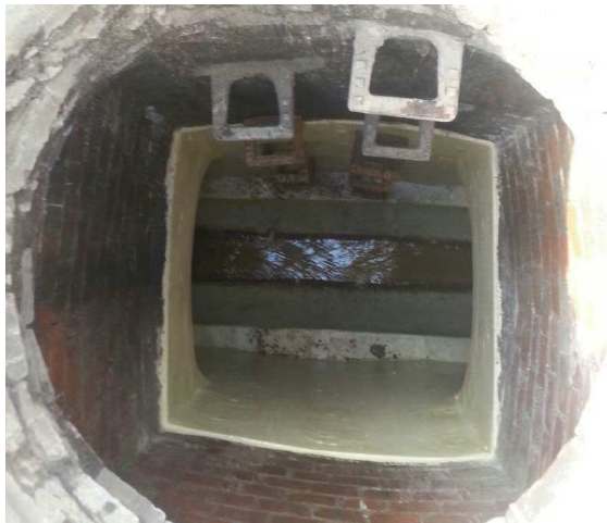
Abb.7+8: Beispiel für eine Ausführung umlaufendes Laminat 10cm über Scheitel
