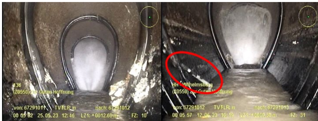
Abbildung 2: (links) Beispielhafte Inkrustationen im Muffenbereich in Haltung 67291011; (rechts) Hindernis (Stange) Stange in 67291013
