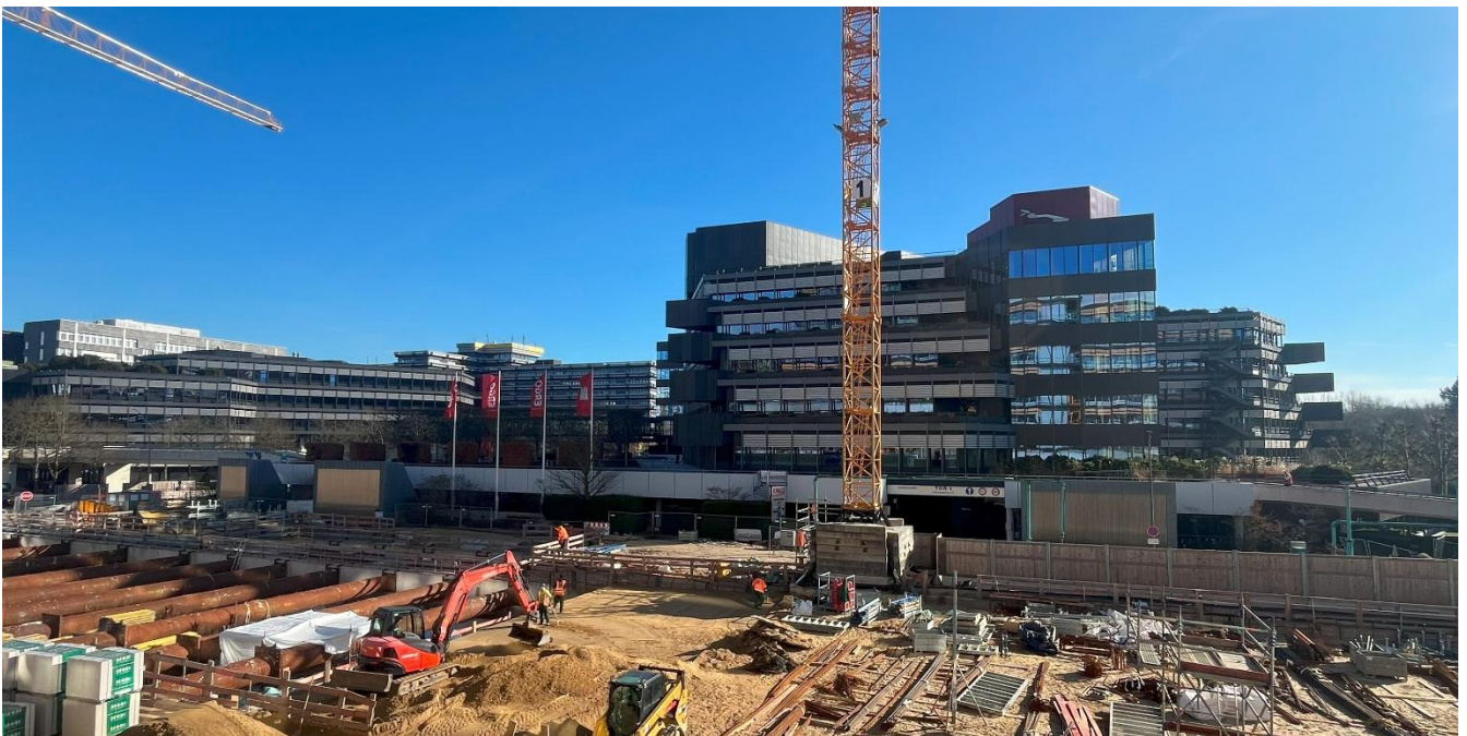
Bild 12: Blick auf Überseering, Baustelle U5 City Nord und Gebäude der Ergo, Überseering 45 – Blickrichtung Ost
