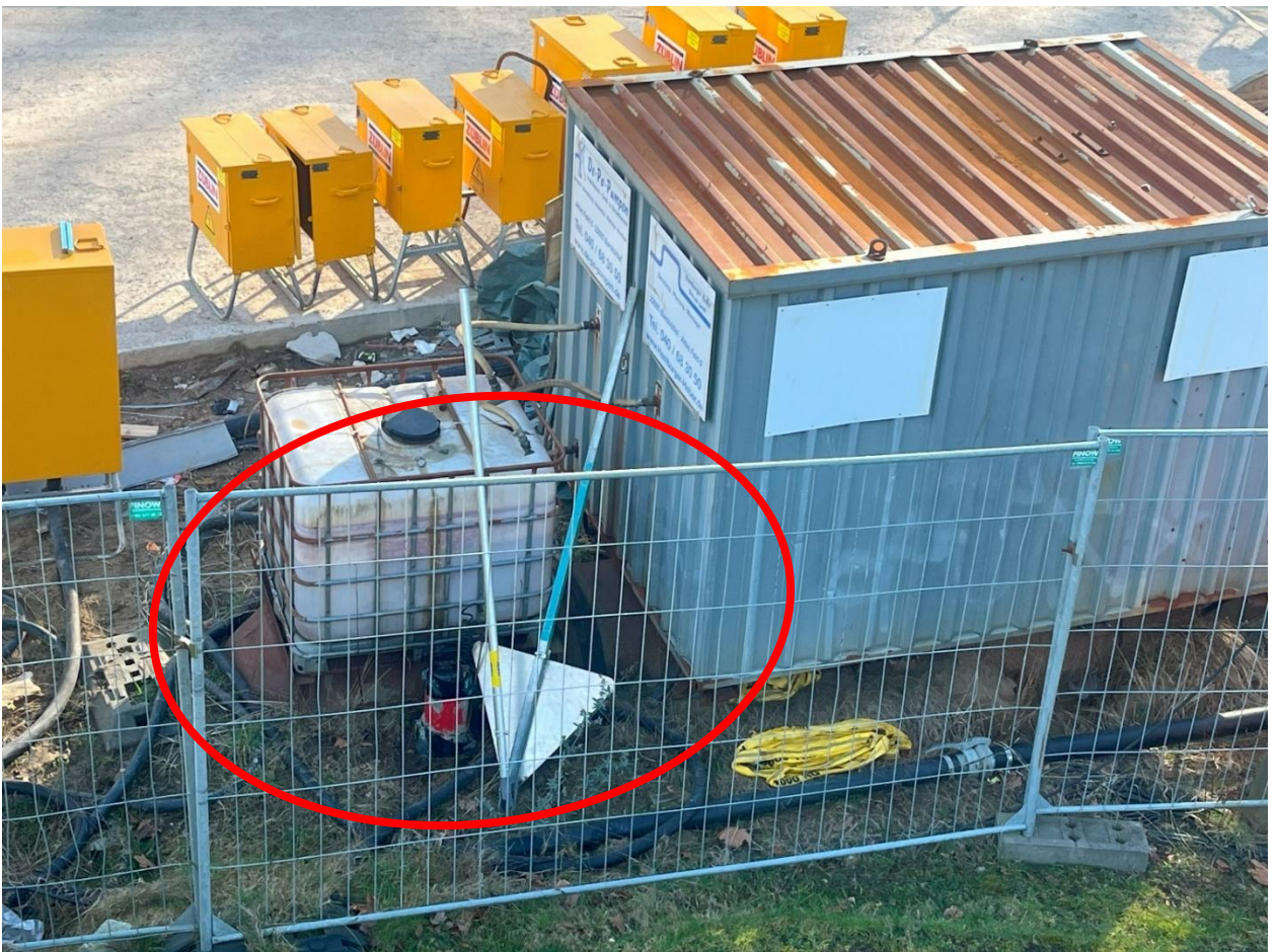
Bild 6: Blick auf Überseering, Übergang der Heberleitung von oberirdisch zu unterirdisch – Blickrichtung West
