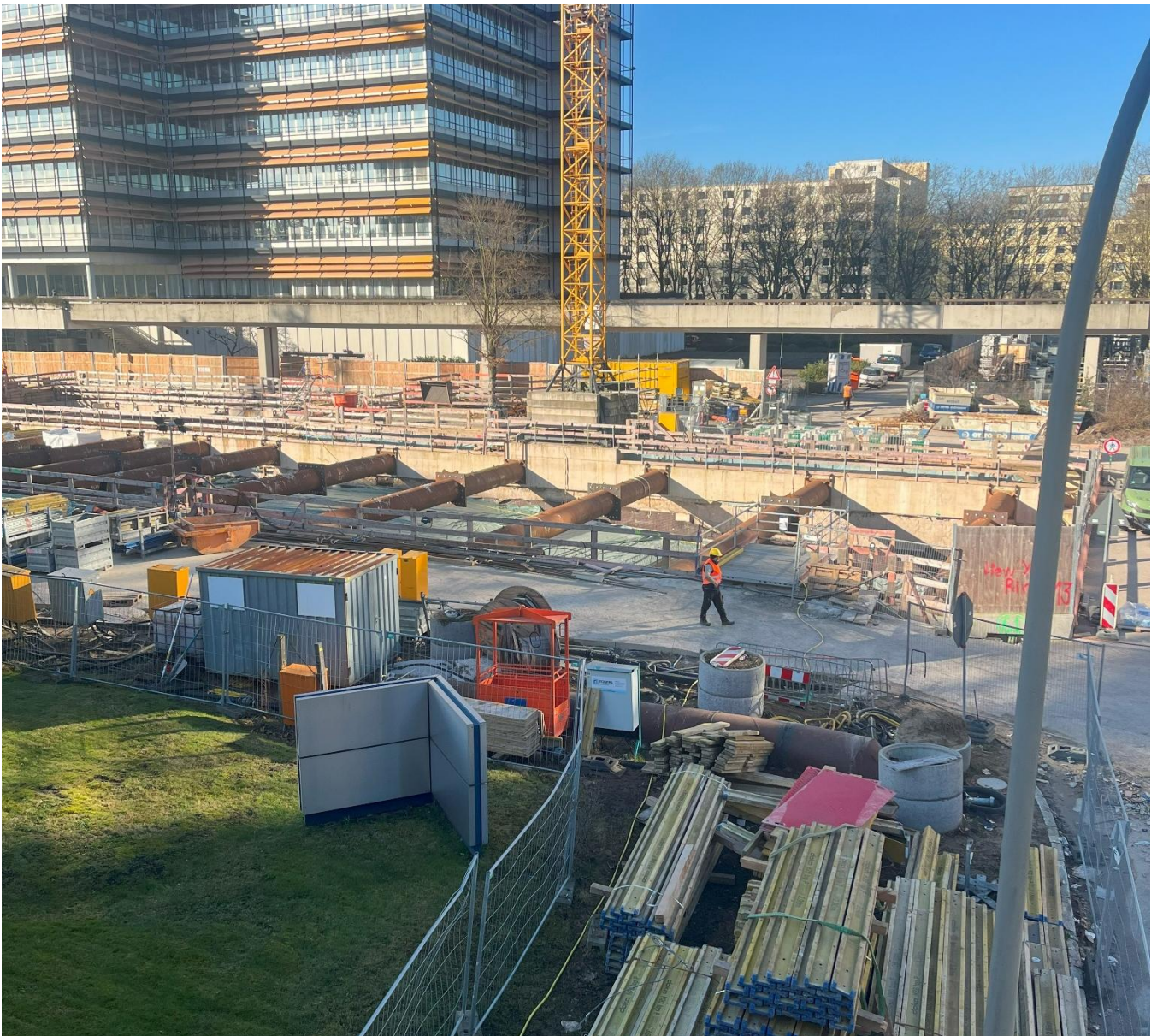
Bild 2: Blick auf Überseering 40, Baustelle U5 City Nord, im Vordergrund temp. Heberleitung – Blickrichtung West
