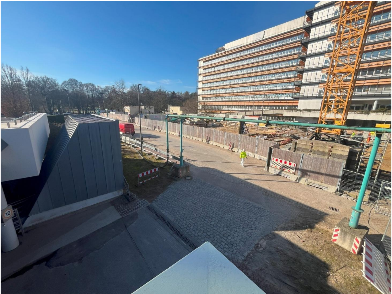
Bild 7: Blick auf Überseering, Garagenzufahrt Überseering 45, R-Siel in türkis kreuzt oberirdisch Garagenzugang – Blickrichtung Südwest
