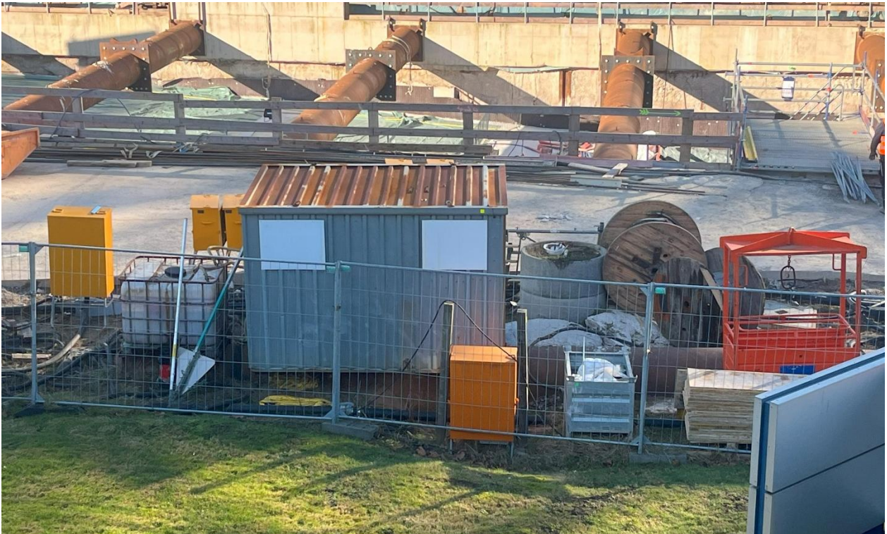
Bild 5: Blick auf Überseering, nördlicher Bereich der Heberleitung und Pumpwerk – Blickrichtung West
