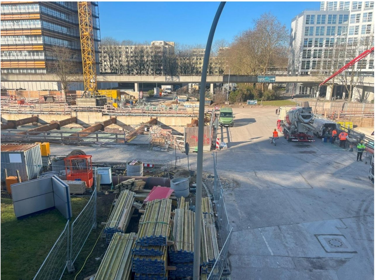
Bild 4: Blick auf Überseering, Heberleitung & Baustelleneinfahrt – Blickrichtung West
